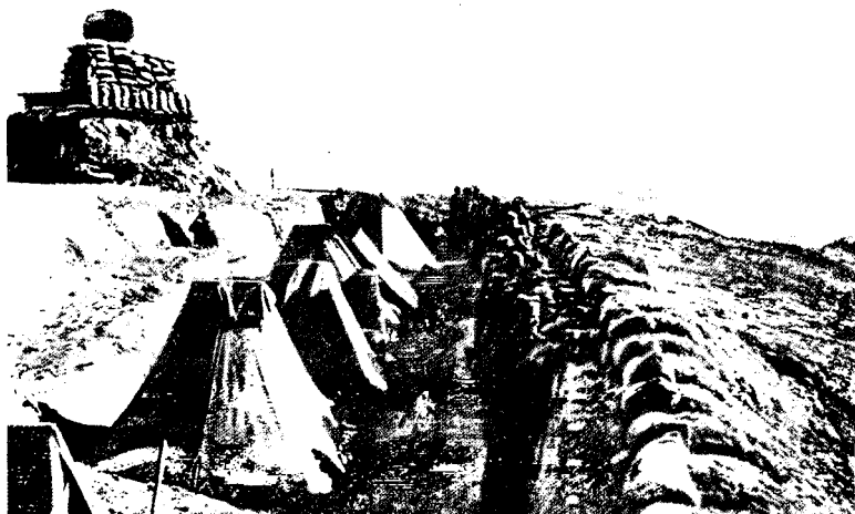
Итальянская траншея у Гаргареша съ установленнымъ сзади электрическимъ прожекторомъ
