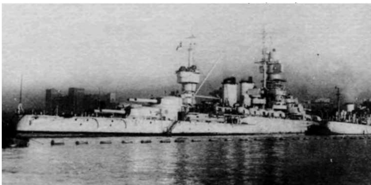
Рис. 5. Повреждения линкора «Кайо Дуилио»
